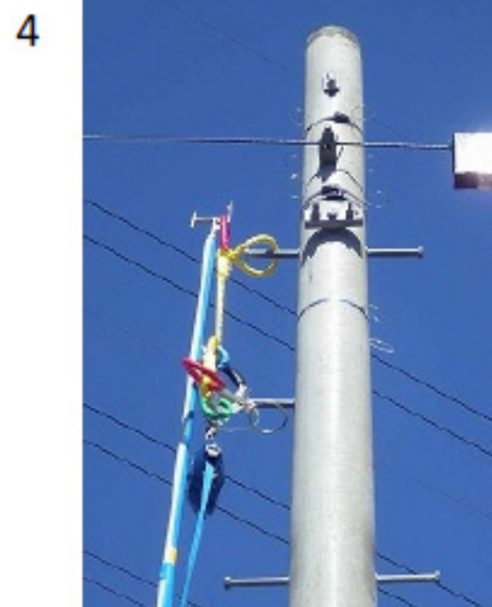
黄色リングを足場ボルト に掛けます
